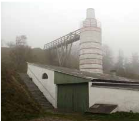
Klim Kalkovn kan renoveres til et støttepunkt
