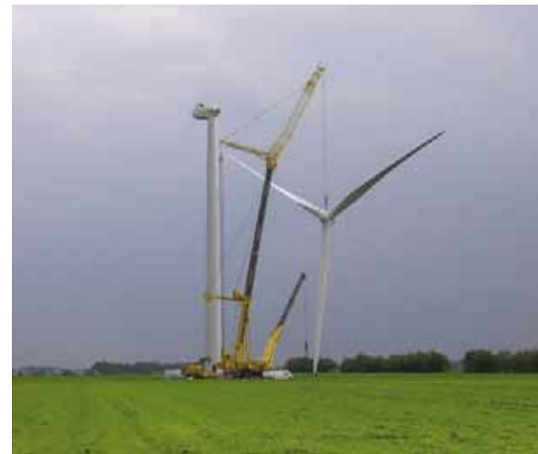
Billede af rotor der hejses op (Foto: Niels Mejlholm)
