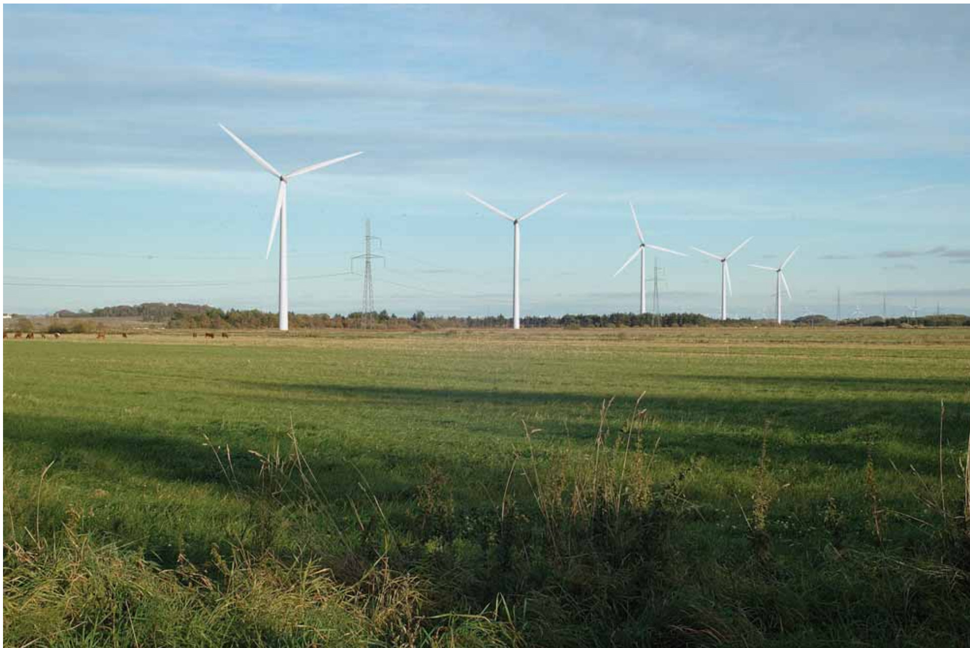
Fotostandpunkt 1 Naboer på Drøstrupvej: Med de 5 nye vindmøller
